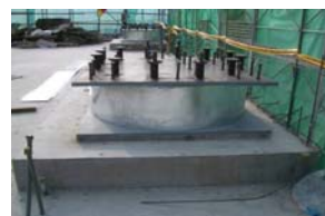
鐵板保護(完成)
