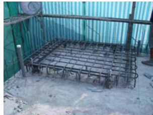
墩座鋼筋綁紮
