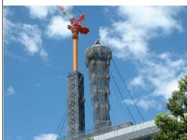
施工中写真(仮支線にてリポート)
