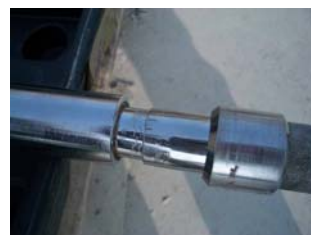
螺栓扭力確認
