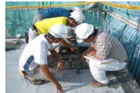
下錨錠板水平位置測量
