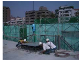
下錨錠板吊裝
